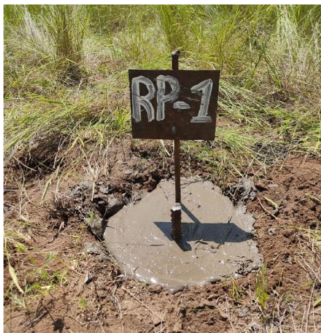
Рисунок 12 – Заложенные репера
